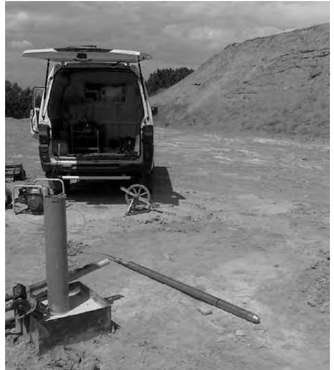
4. ábra. Mérési előkészületek a Bánhidai Erőmű zagyterén, a Bhz-1 megfigyelőkút környezetében
