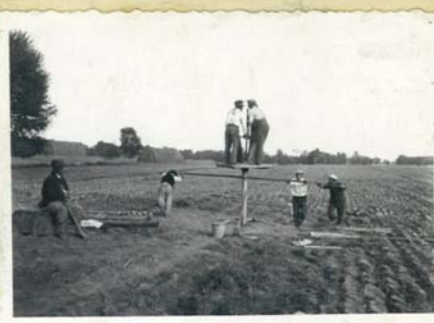
2. ábra. Robbantólyuk fúrása kézi erővel.
