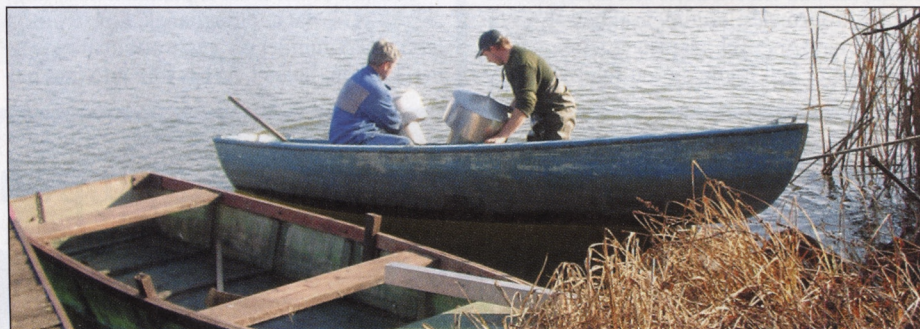
Vízkivételi szűrőfej beszerelése
