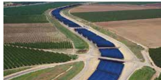
Indiában a Narmada csatorna felett alkalmazták először a nyomvonalat részben befedő, állványokra telepített napelemeket
