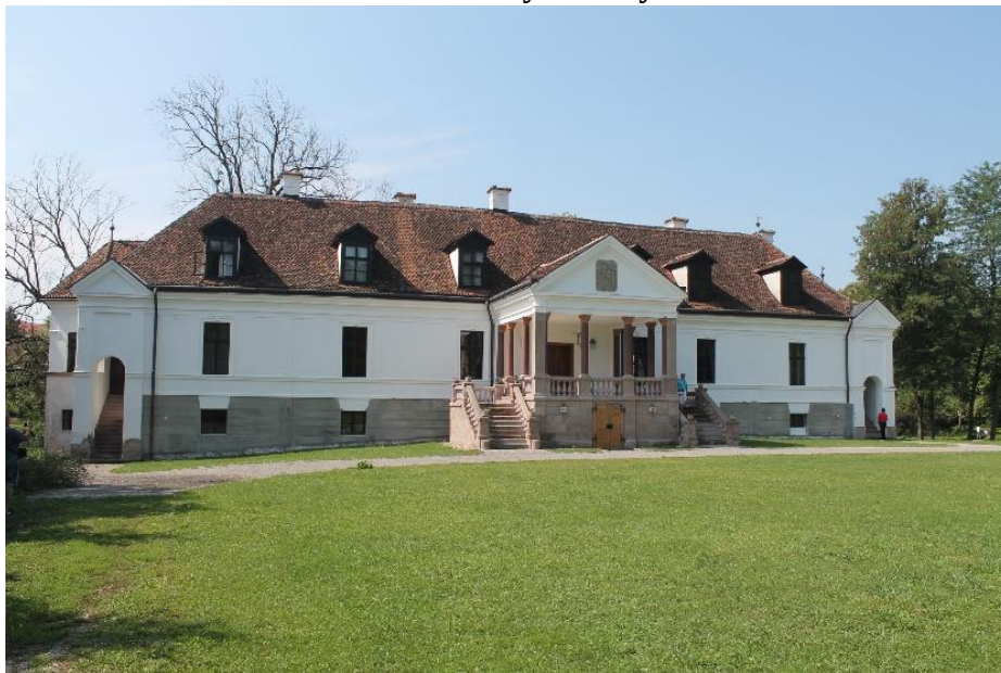
1. ábra: A miklósvári Kálnoky-kastély keleti homlokzata
