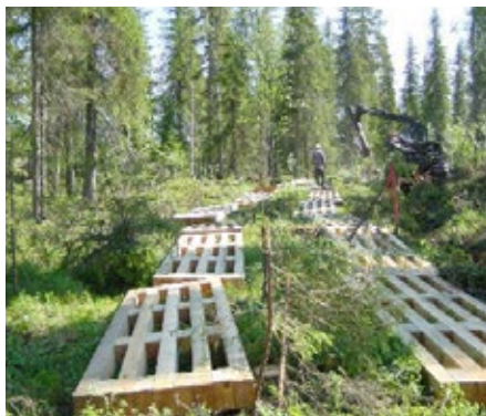
5. ábra. Útpálya fából készült rácsos tartó- szerkezetekből (Lassila, K., 2002)
