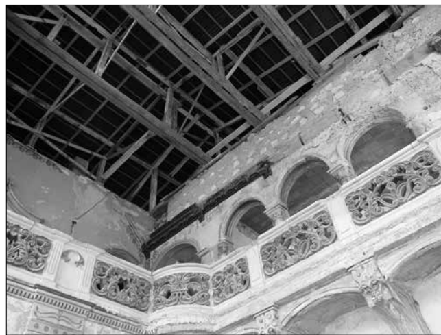
Pucér gerendák tartják a tetőszerkezetet...
