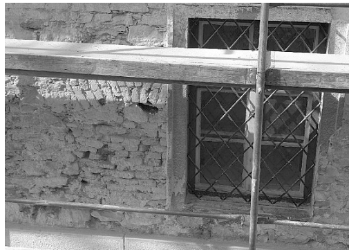
A nyugati homlokzat levert vakolata alatt rejtőző építéstörténet (i-quadrat-fotótár)
