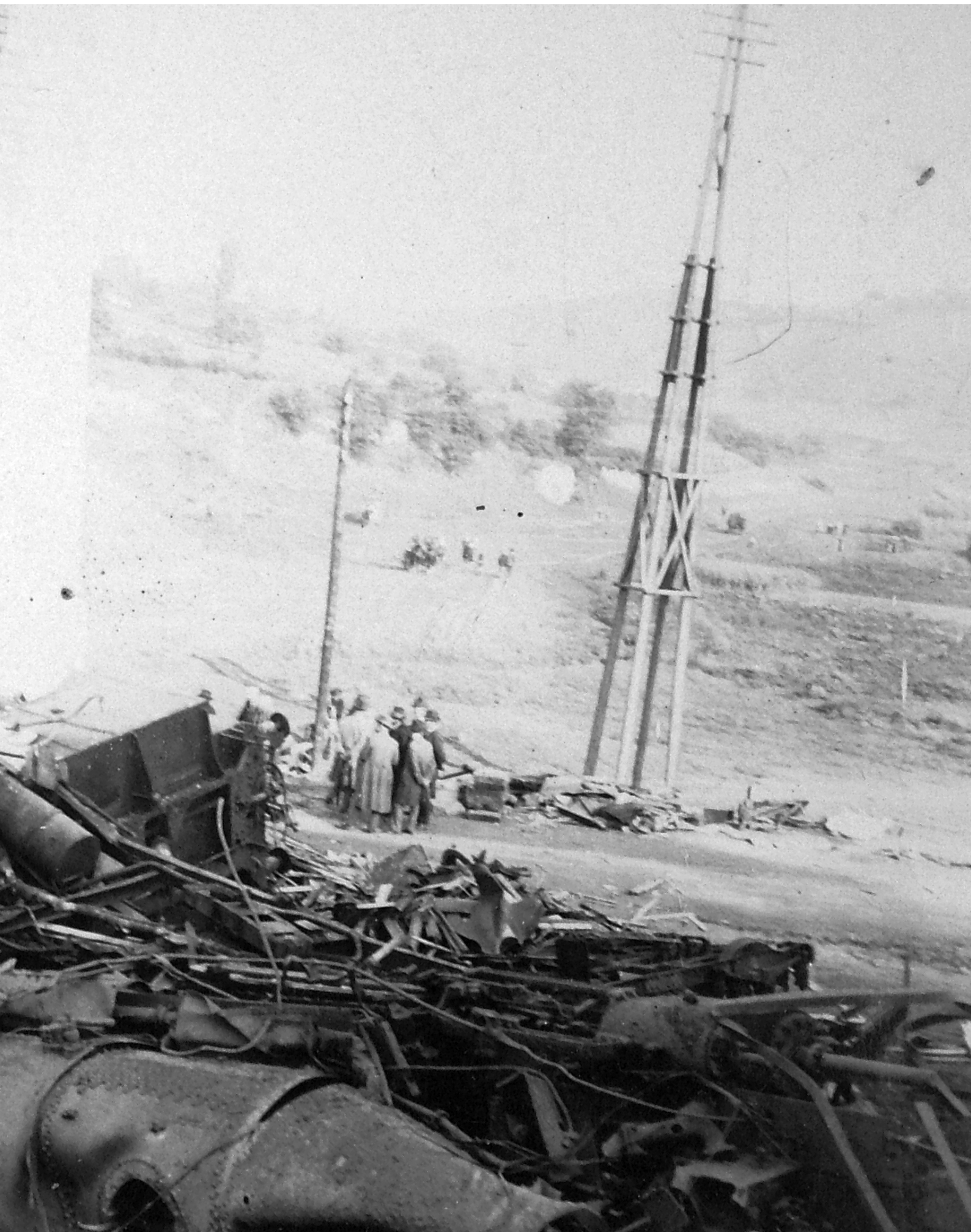
A biatorbágyi vasúti viadukt az 1931. szeptember 13-ai merénylet után (Fotó: Fortepan / Lencsés Zoltán adományozó)
