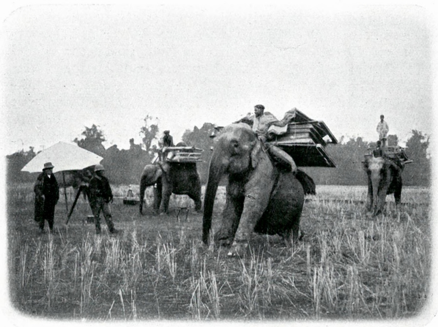
Fig. 2. Transport des parois des maisonnettes en Upper-Assam.
