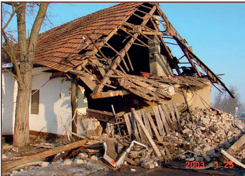
A Levegő csárda romjai az autós tragédia után
