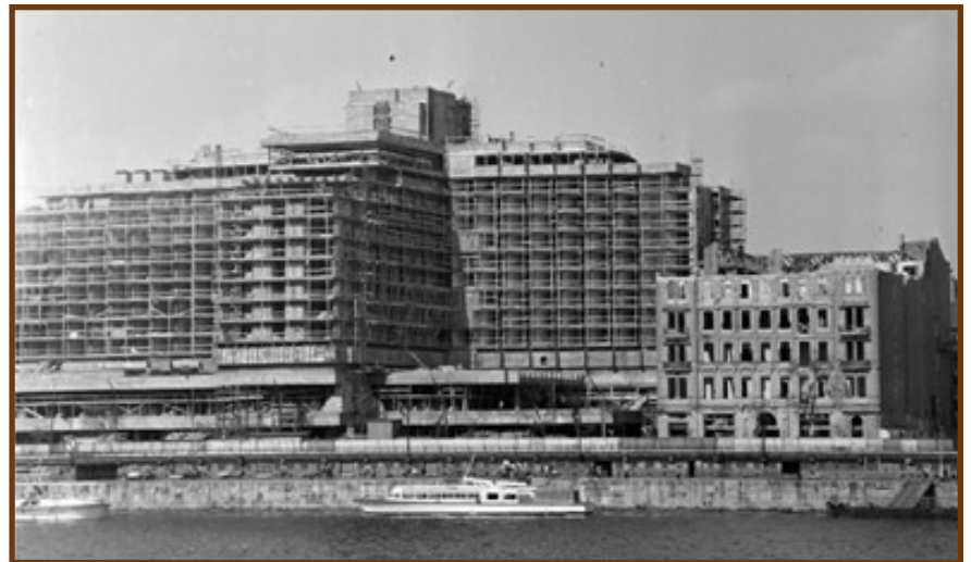
A Duna Intercontinental Szálloda építése.
