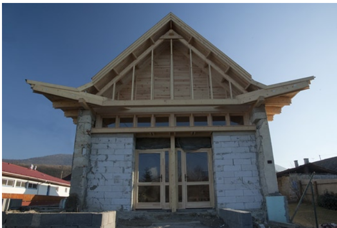
A Bükk kapujában, Felsőtárkányban épülő Kárpát túraközpont
