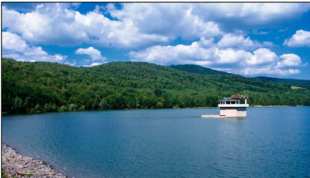
A víztározó vezérlő épülete
