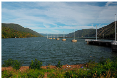
A Vaskapu I. vízerőmű felső bejárata. A világító oszlopok pont ott sorakoznak, ahol egykor a híres Prigrada sziklapadon bukott alá a hőmpölygő Duna. Távolban Orsova látható. (Fotó: Mályi József 2022. október)
