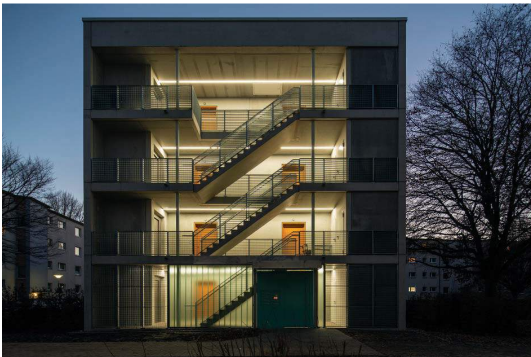
Az egyik mintaépület északi homlokzata, termikus burkon kívüli közlekedő- és merevítőmagja
