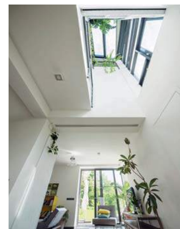
A szolárkürtő a DK-i tájolású üvegezéssel és a tető-felülvilágítóval a természetes megvilágítás (vizuális komfort), a téli szoláris hőnyereség és a nyári, illetve az átmeneti időszakokban szükséges természetes átszellőztetés céljából
