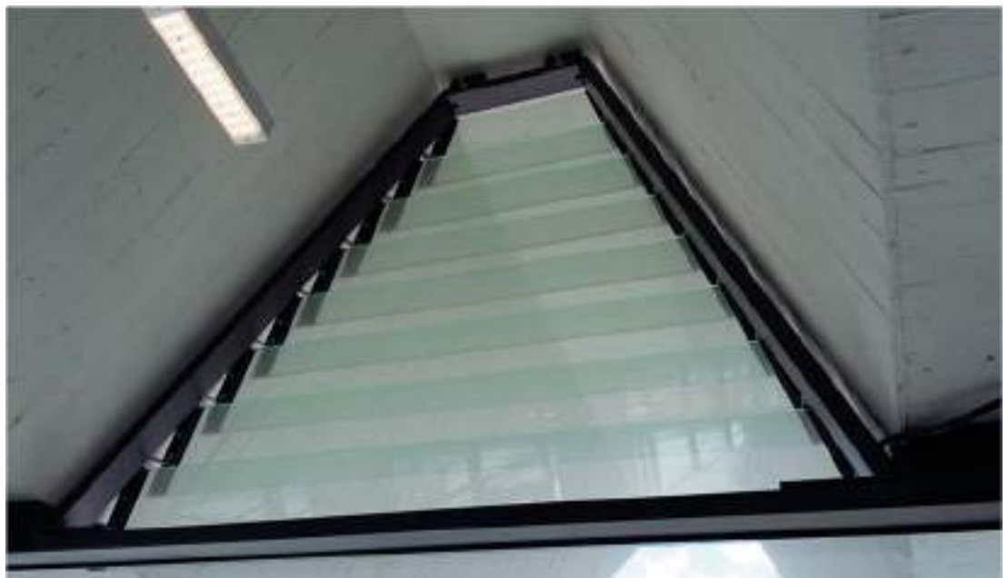
2. kép Legyezőmű alatti üveglamella-soros kiszellőzőelemek
