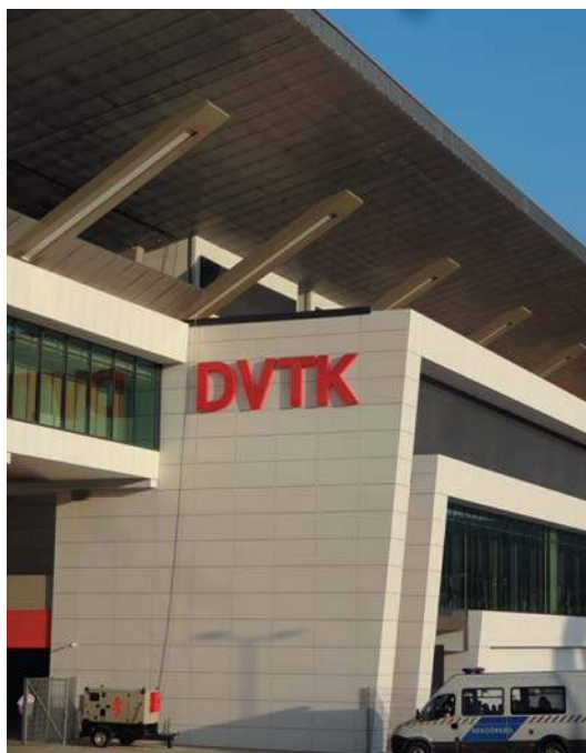
23. ábra Véghomlokzat kifelé dőlő bútüfelületekkel és a keretező tagozatokkal (fotó: Pataky Rita)
