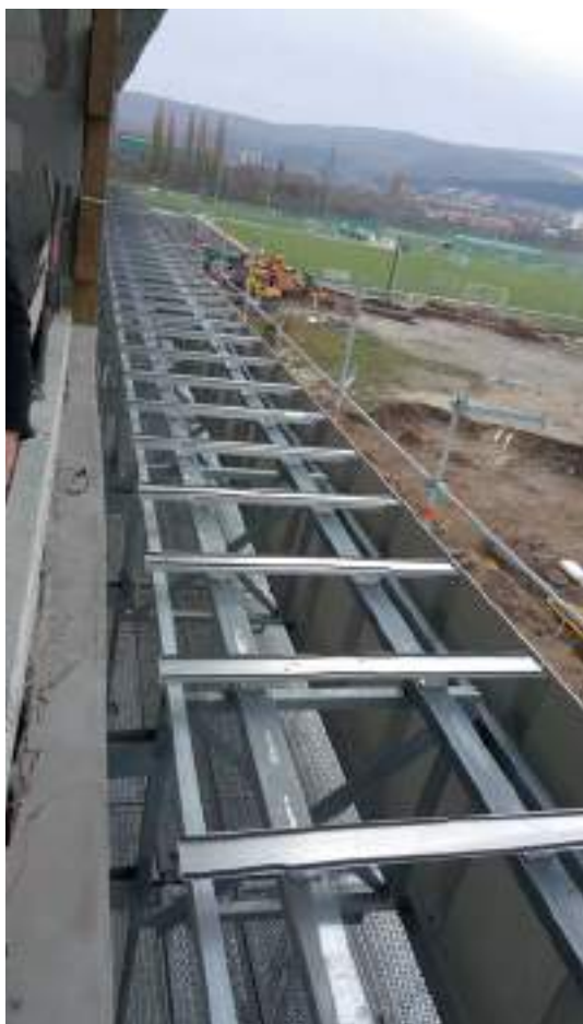
21. ábra Legfelső szintű tagozat vízszintes aljzatszerkezete (fotó: Áts Árpád)
