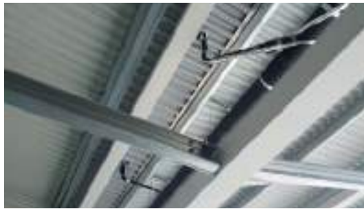
16. ábra A pillangótető vápacsatornája alulról a víznyelőkkkel (fotó: Áts Árpád)
