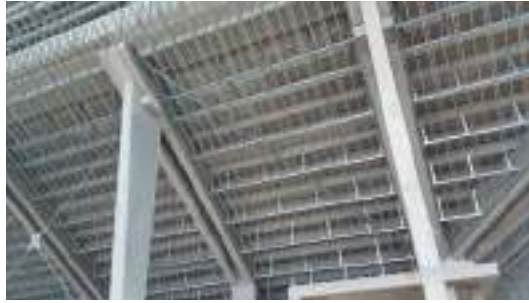
7. ábra A lelátó előregyártott vasbeton szerkezete a burkolat aljzatával (fotó: Áts Árpád)
