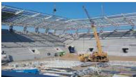
10. ábra A pillangótető acélszerkezete (fotó: Smaragly László)
