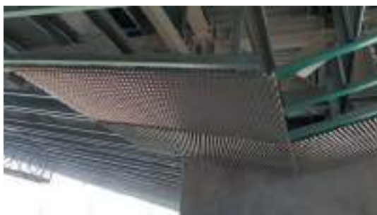
12. ábra A tetőszerkezet alsó síkjára szerelt fémlemez burkolat (fotó: Áts Árpád)
