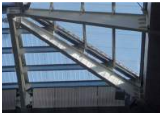
11. ábra A polikarbonát és a porszórt acél trapézlemez fedés váltása (fotó: Pataky Rita)
