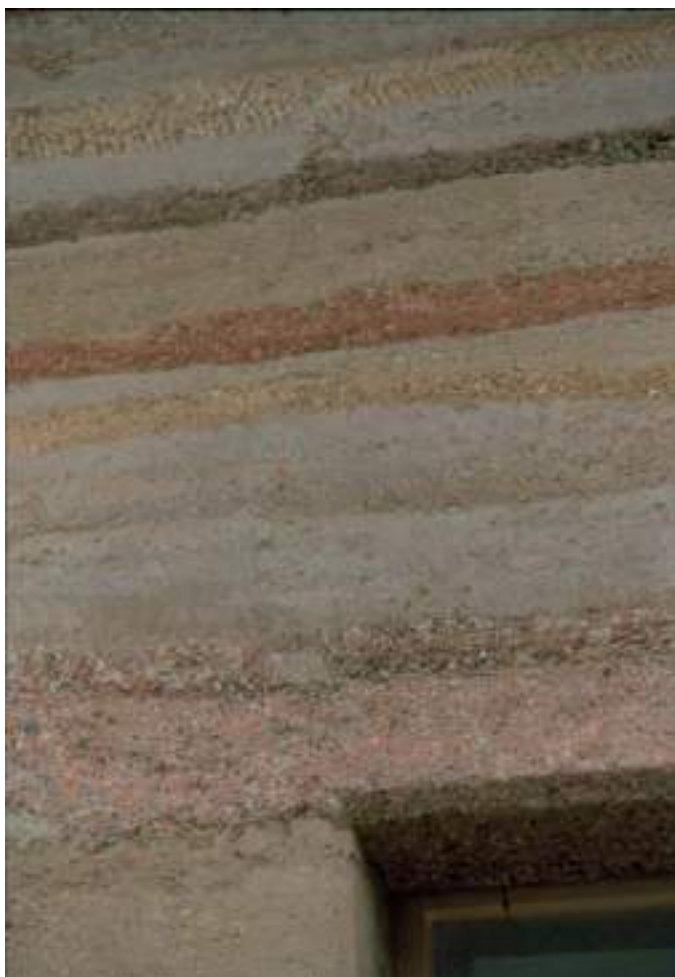
5. ábra Hagyományostól eltérő méretű, díszítő, páraszabályzó szerepben épített vertfal Feldkirchben [foto: Medgyasszay Péter]
