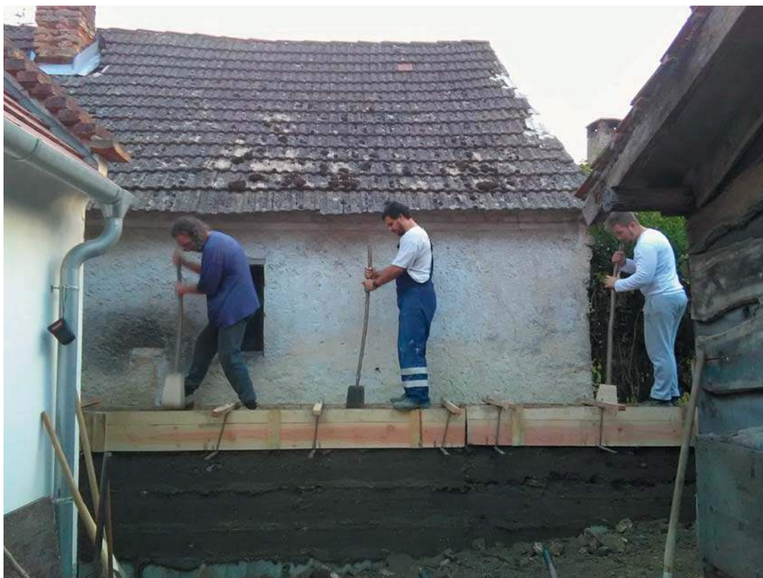
4. ábra Vertfal építés közben [fotó: Bihari Ádám]
