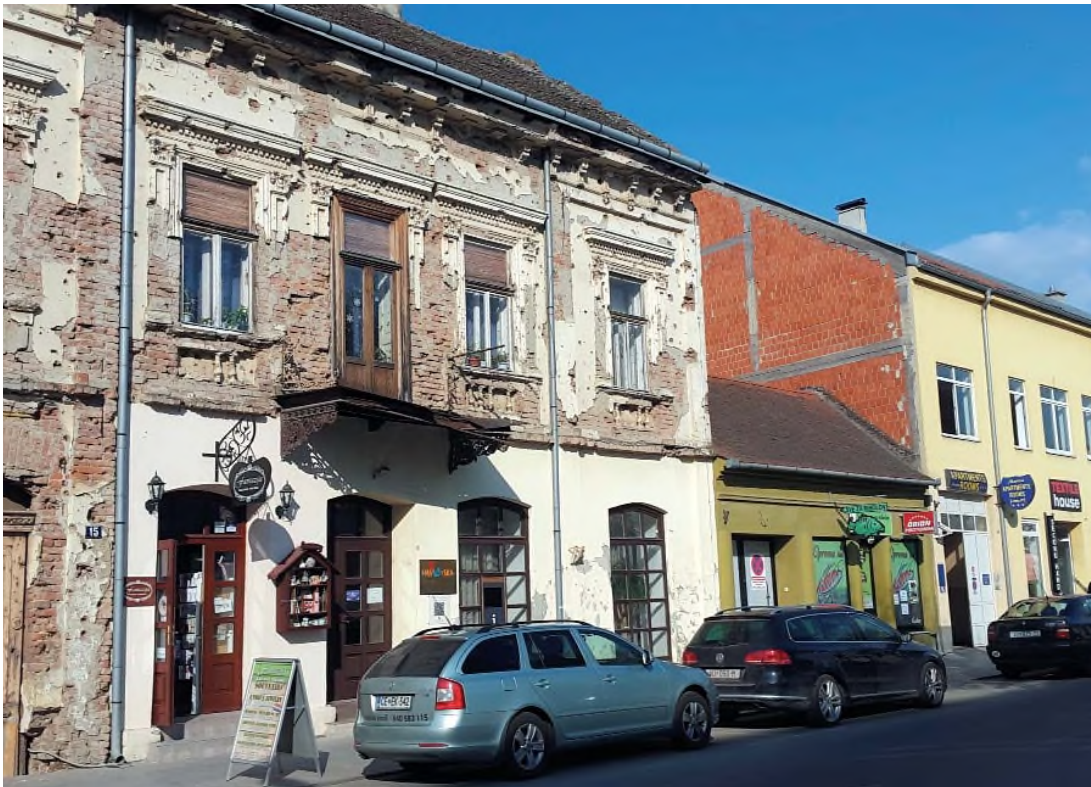
Mementó: a felújított főutcában felújítatlanul maradt épület 2017-ben
