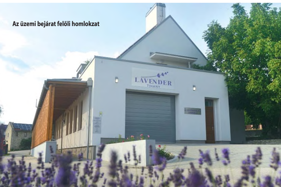
A visszahúzott vágás ereszmegoldás és a filterszerű hosszanti tornác egyszerű alapformákra bontja a korábban zavaros tömegelrendezésű épületet
