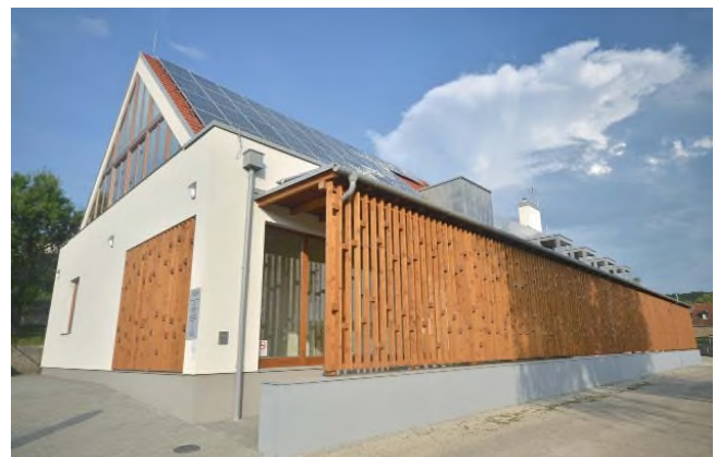
A visszahúzott vágás ereszmegoldás és a filterszerű hosszanti tornác egyszerű alapformákra bontja a korábban zavaros tömegelrendezésű épületet
