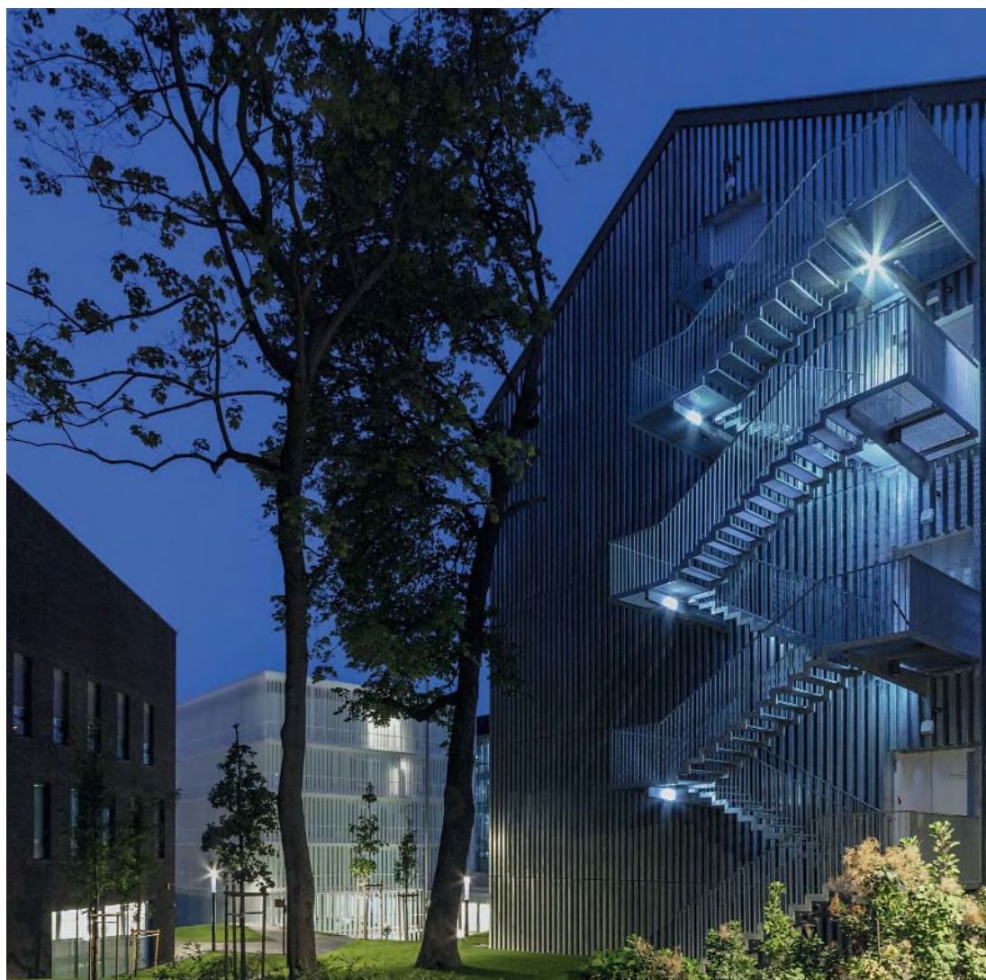
Jobbra a Farkasdy-ház bütüjére illesztett, homogenizáló tűzlépcső, balra a technológiai park – műhelyház –, szemben a MOME UP
