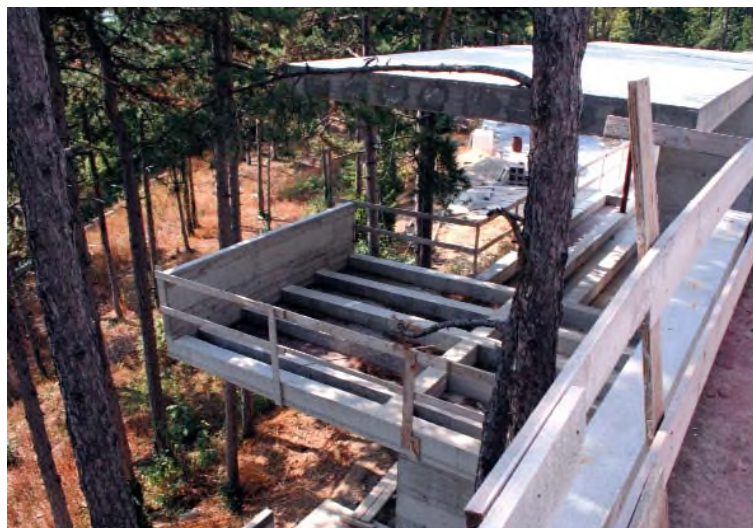
7. kép. A megépült konzolos felülbordás lemez és az utófesztített lemez együtt
