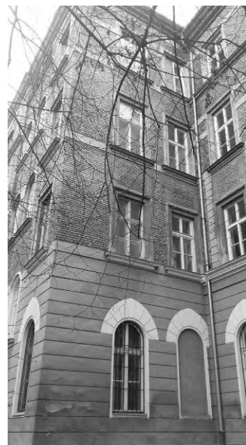
A felújítás előtti udvari homlokzat
