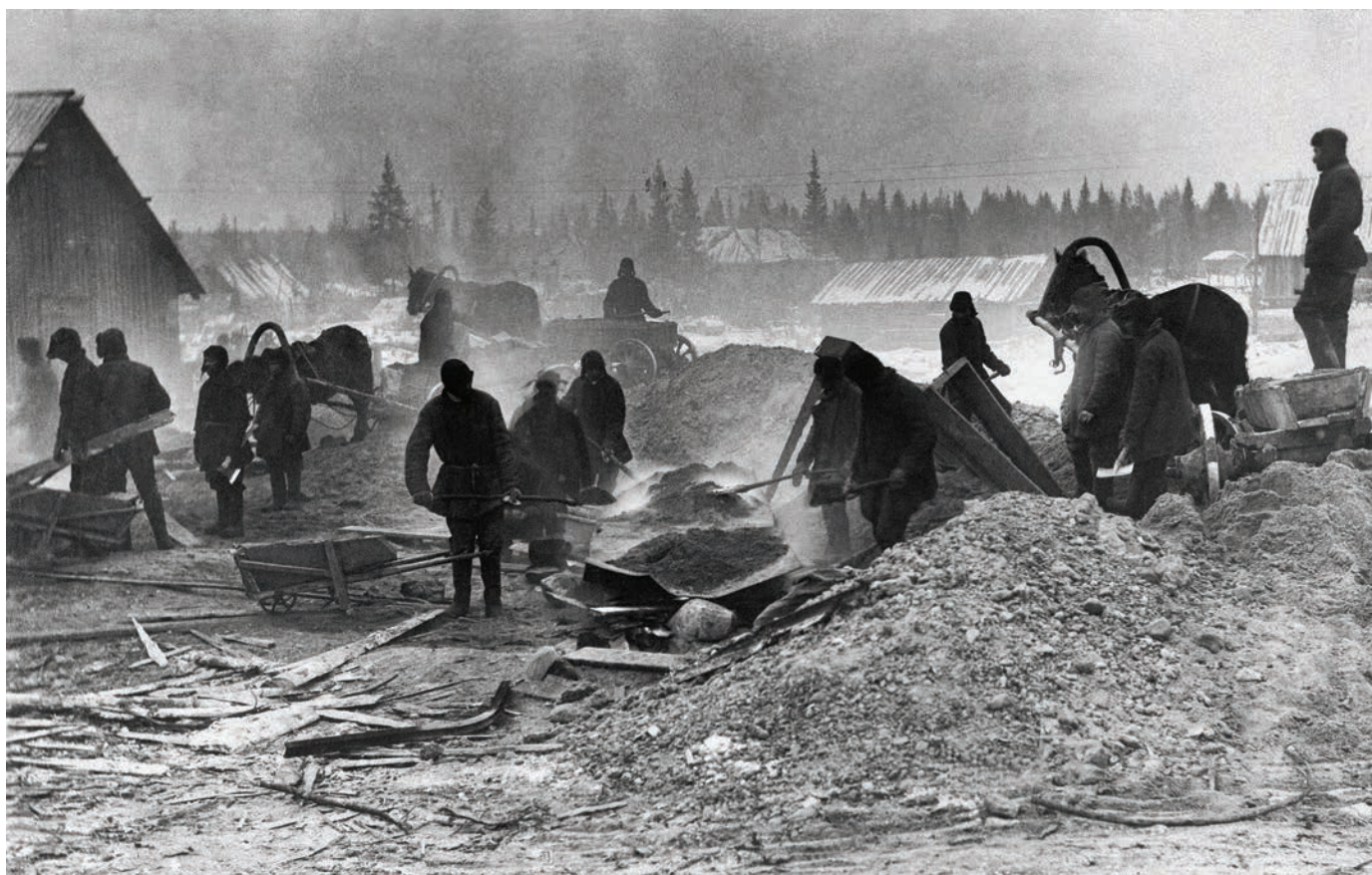
A habarcs hűtése (hogy megkössön a fagyos vízben) a Balti–Fehér-tengeri csatorna építésén, 1931–1933 (Gulag-gyűjtemény, Tomasz Kizny)
