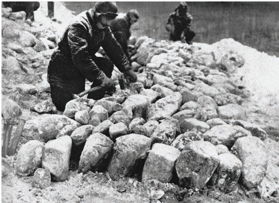
A Balti-Fehér-tengeri csatorna építése, 1931–1933 (Gulag-gyűjtemény, Tomasz Kizny)
