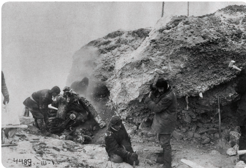
A Balti-Fehér-tengeri csatorna építése, 1931–1933, máglyákat égetnek a talaj felolvasztásához (Gulag-gyűjtemény, Tomasz Kizny)
