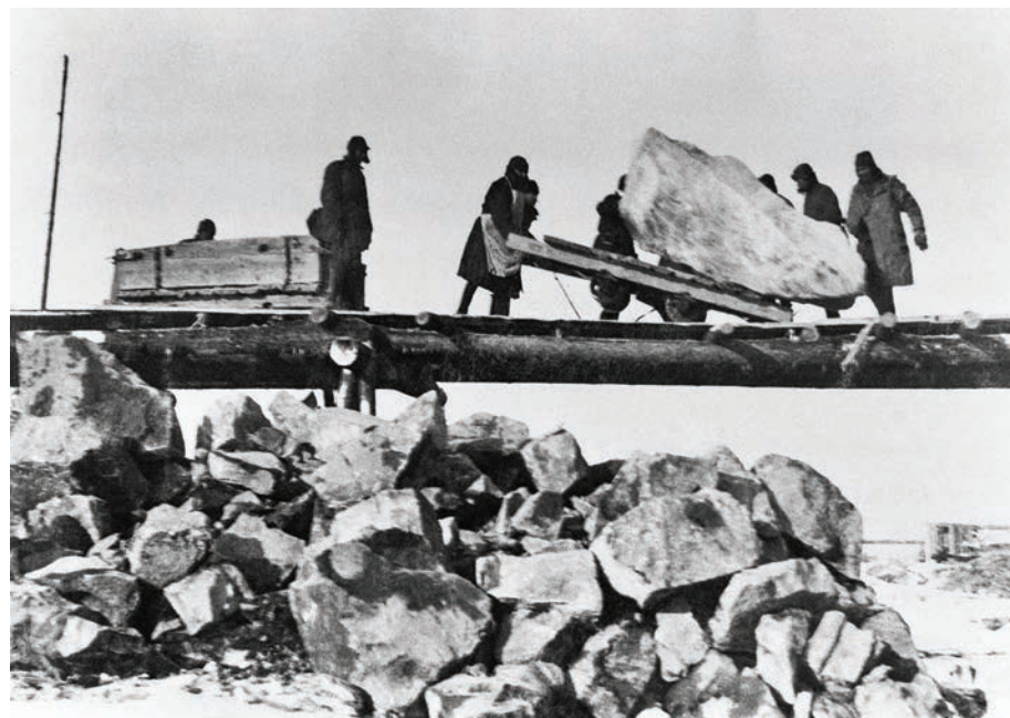
A Balti-Fehér-tengeri csatorna építése, 1931–1933, kőgát építése (Gulag-gyűjtemény, Tomasz Kizny)
