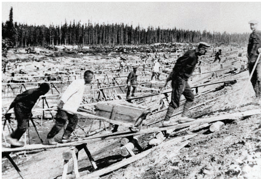
A Balti-Fehér-tengeri csatorna építése, 1931–1933 (Gulag-gyűjtemény, Tomasz Kizny)
