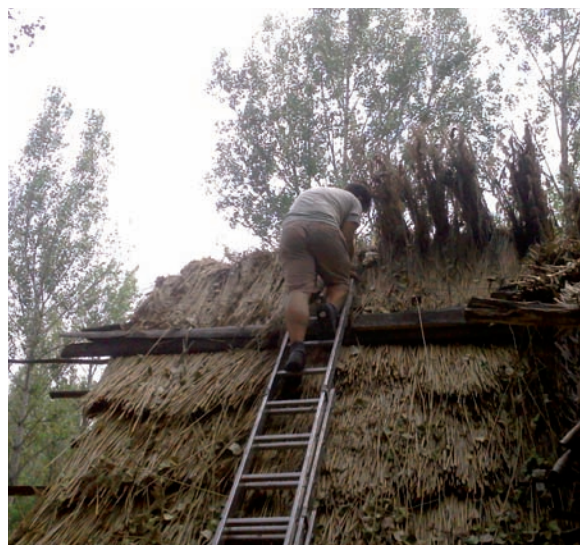
5. kép: A tető náddal való befedése
