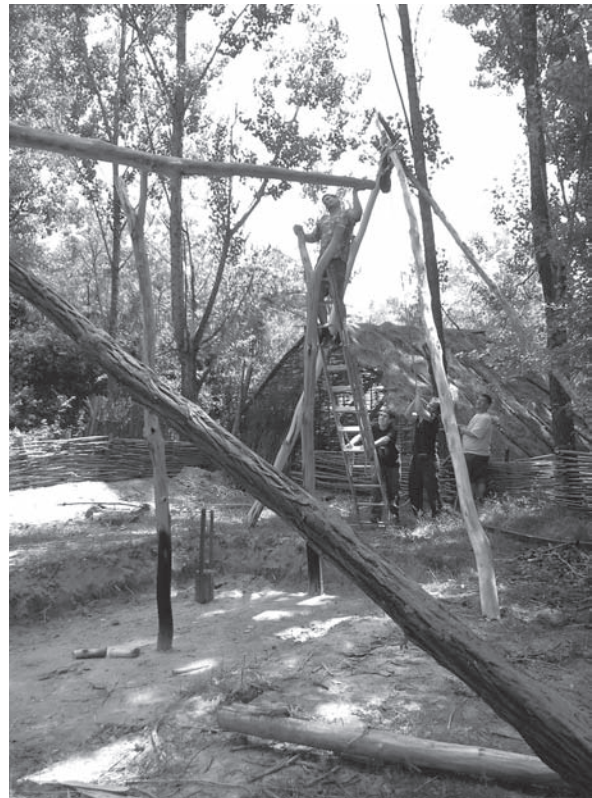
3. kép: A tetőszerkezet építése
