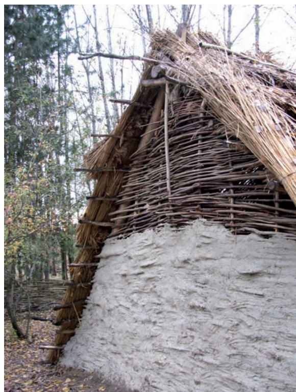
6. kép: Az oldalfal tapasztása
