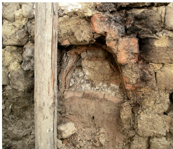
16. kép: Elfalazott kemencenyílás a konyha és a kisháló között
