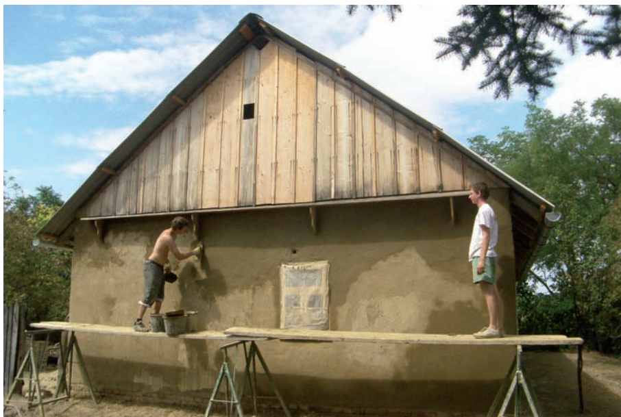
20. kép: A keleti homlokzat felújítás alatt, 2012.
