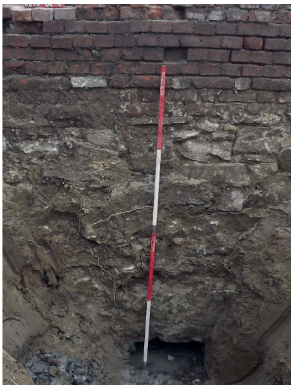
17. ábra. A főtorony alapozása.
