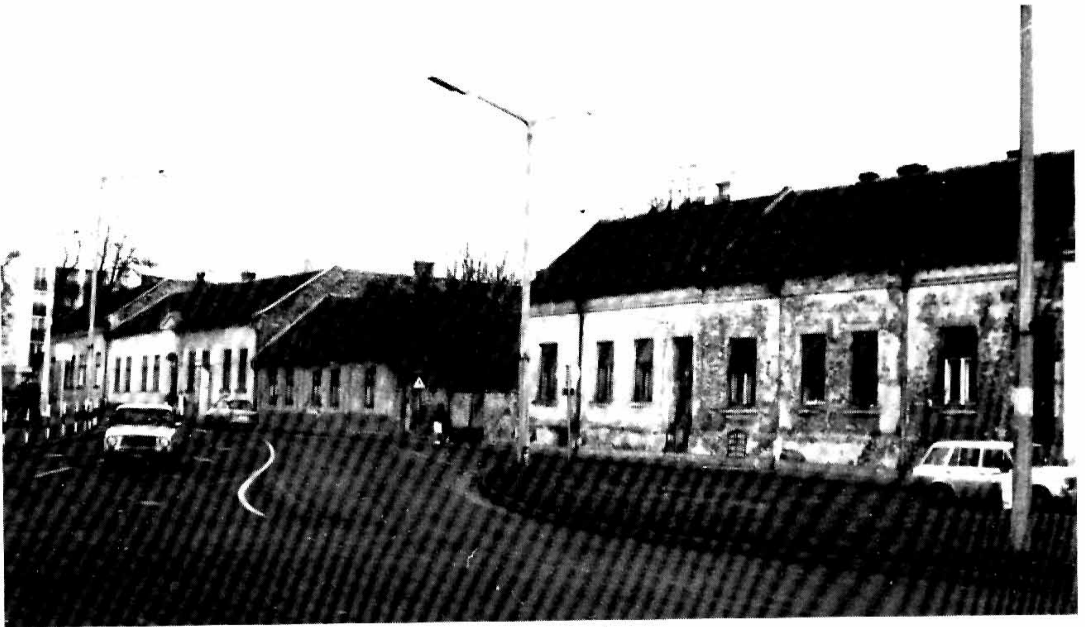
1. kép. Az egykori Honvéd utca mai képe. Az előtérben lévő épületek helyén állt Galimberti Sándor szülőháza, melyet a század első éveiben lebontottak. Helyén eklektikus stílusú polgári lakóházak épültek. A lebontott épület jellegéről képet alkothatunk a Honvéd utca 4. sz. ház középső, alacsonyabb tömbje alapján, amely szintén a múlt században épült.
