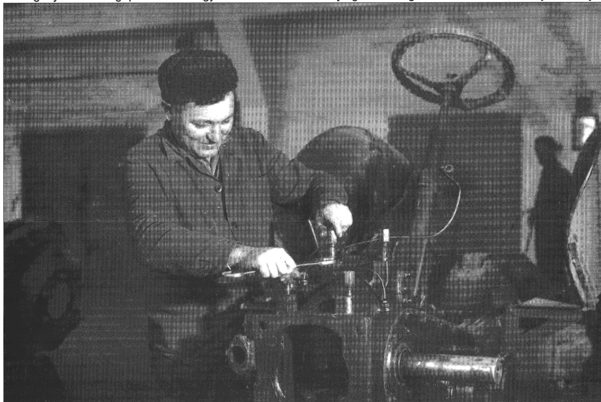
G-35-ös traktor főjavítása, Tabi Gépállomás, 1960. (SMMI újkortörténeti gyűjtemény)
