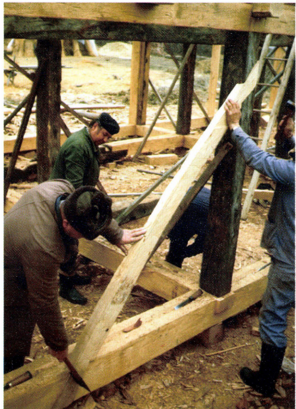
6. ábra: Ívesen faragott támasz behelyezése
