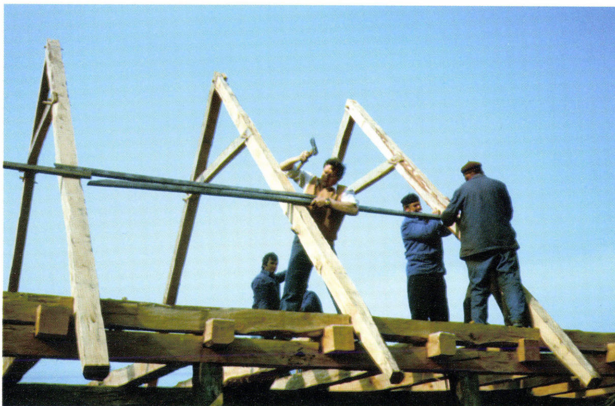
7. ábra: Szalupárokat rögzíti: Bellai Endre, Horváth Laci, Vass Jóska és Janika Szabó
