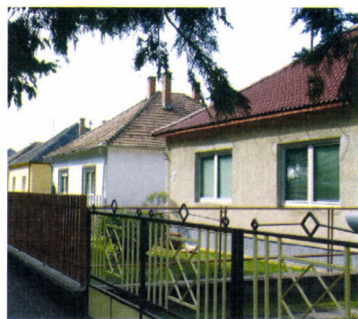
Kockaház-sor Nagyatádon (Huszár Endre fotója, 2006)
