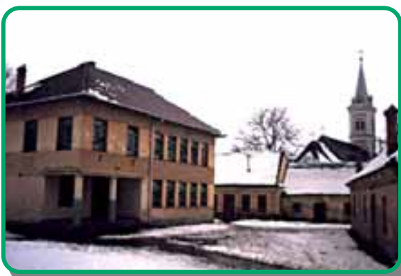
Az evangélikus egyház iskolaépülete
