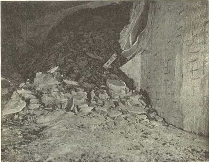
Fig. 5. Eingestürzte Salzwand an der Grenze des Salztone im Rudolf-Schacht. (Originalaufnahme.)
