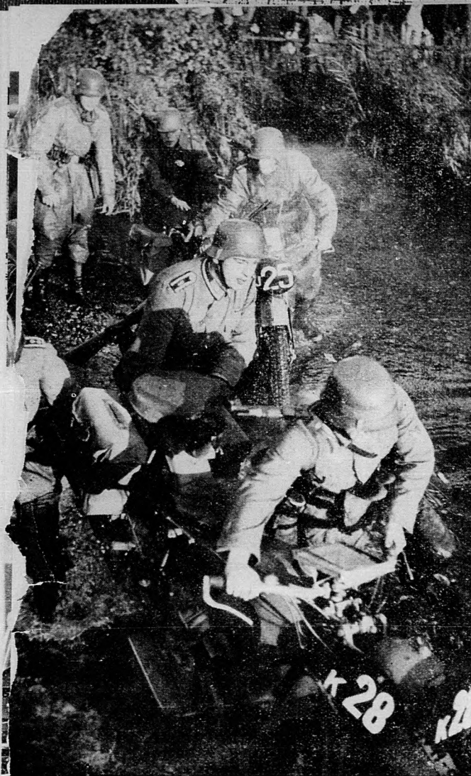
Árkon-bokron, tűzön-vízen át tör célja felé a motoros felderítő járőr
