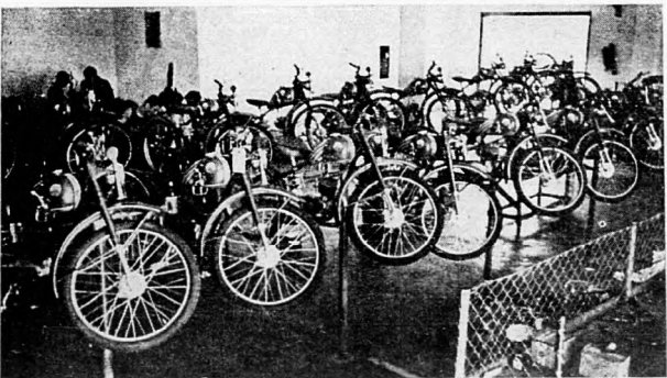
A Mátra-gyár szerelőcsarnoka a praktikus montázs-állványokkal.
