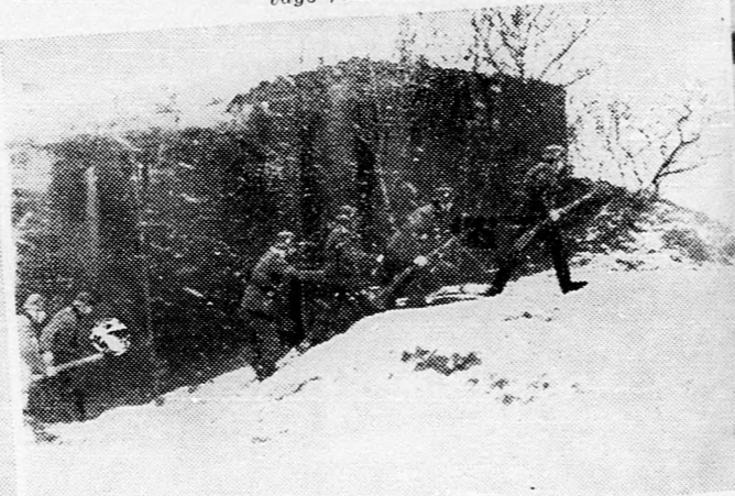
Terepkutató járőr hagyja el a Siegfried-vonal egyik beton-erődjét. Az erődvonal előtti terep állandó felderítése életbevágó fontosságú.
