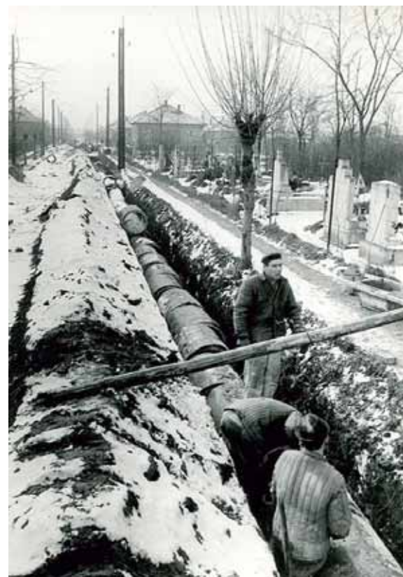
Szennyvízcsatorna építése 1962-ben az Iparvasút utcában
