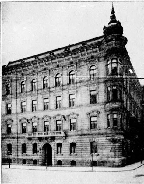
Épülő Budapest. (Gátl Bertalan építkezéseiből.)
