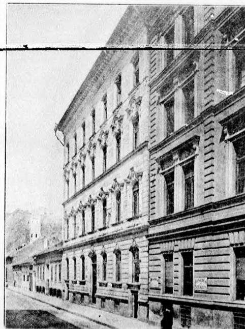
Épülő Budapest. (Szabó János építkezéséből.)
