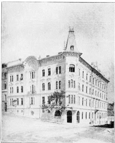
Épülő Budapest. (Székely Vilmos építkezéseiből.)
