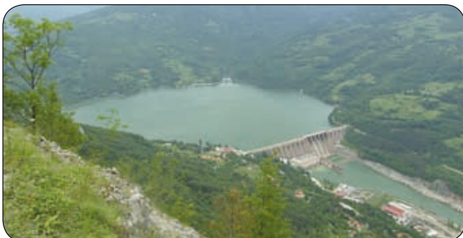
Vízierőmű építése közben keletkezett Perućaci-tó
