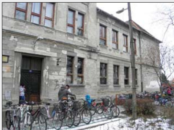
Tetőfelújítás és ablakcsere várható
