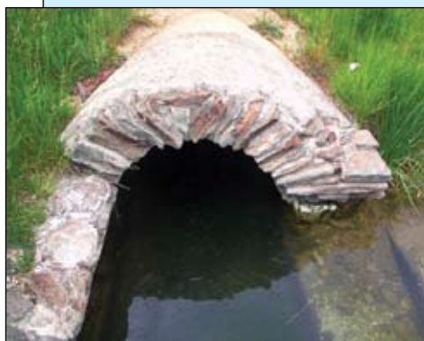
2003 tavaszán bukkantak rá a római kori vízvezetékre Szombathely közelében. Feltételezések szerint a 28 kilométeres, 40 cm vastag falú csatorna napi 345 ezer liter ivóvizet volt képes szállítani Savaria, azaz a mai Szombathely lakosságának
