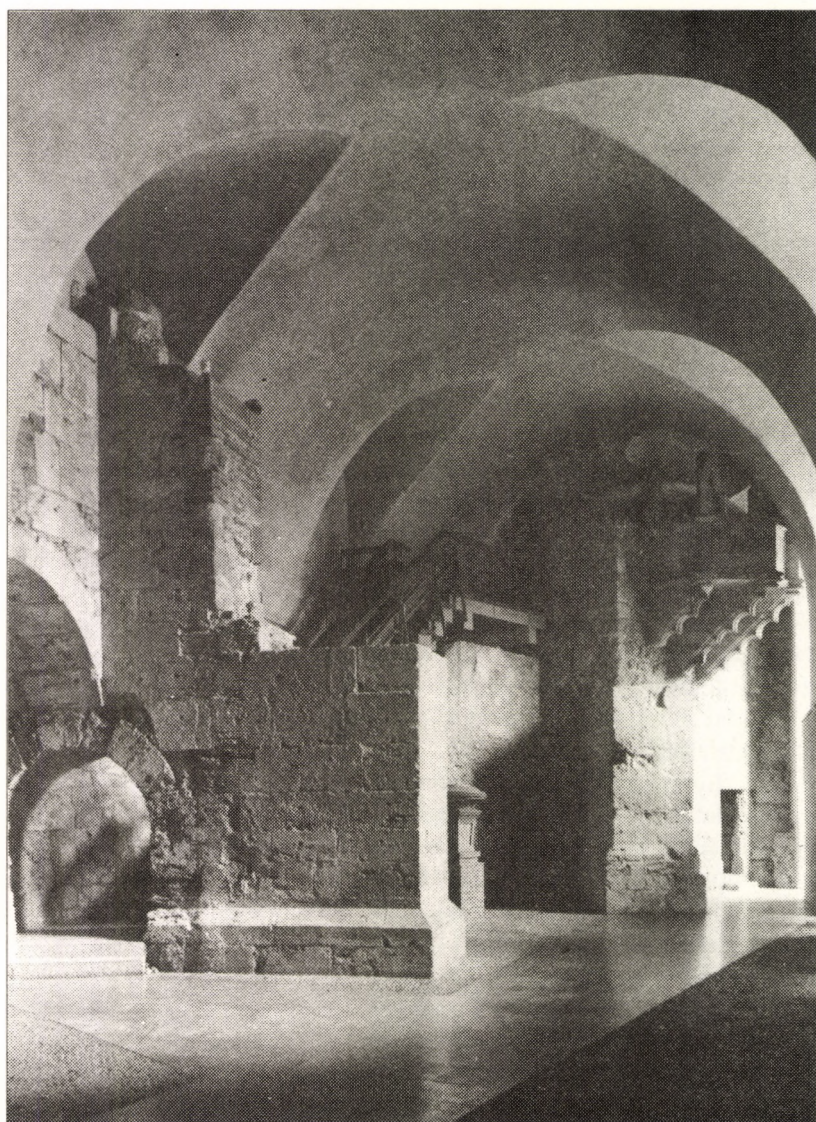
BUDAI VÁR, KIRÁLYPINCE. GÓTIKUS PALOTA TÁMPILLÉRE ÉS ERKÉLYKONZOLJAI
