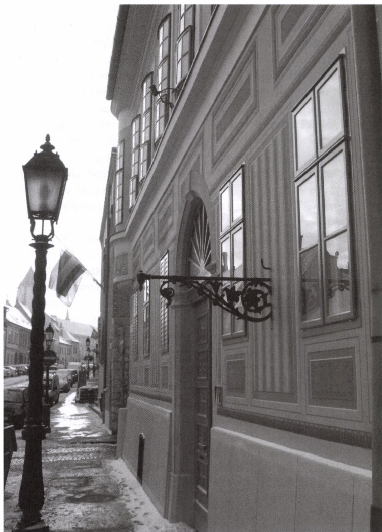
EGY BÉCSIKAPU TÉRI LAKÓHÁZ HOMLOKZAT-HELYREÁLLÍTÁSA, RÉSZZELGES FELÚJÍTÁSA, BUDAPEST
