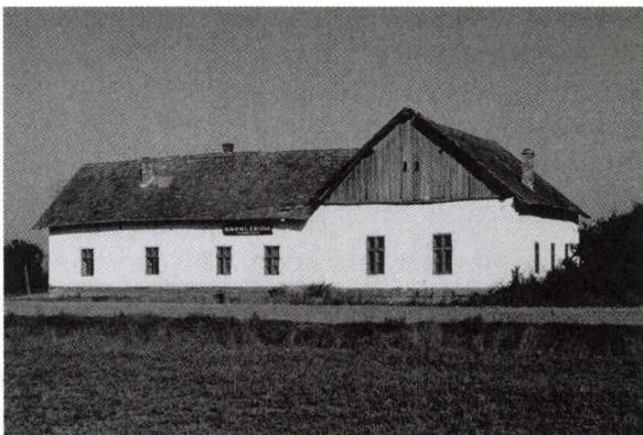
Pusztaközpontban, az 1883-ban alapított, 1884-1960 között használt Baraczkosi Olvasókör épülete bontás előtt
