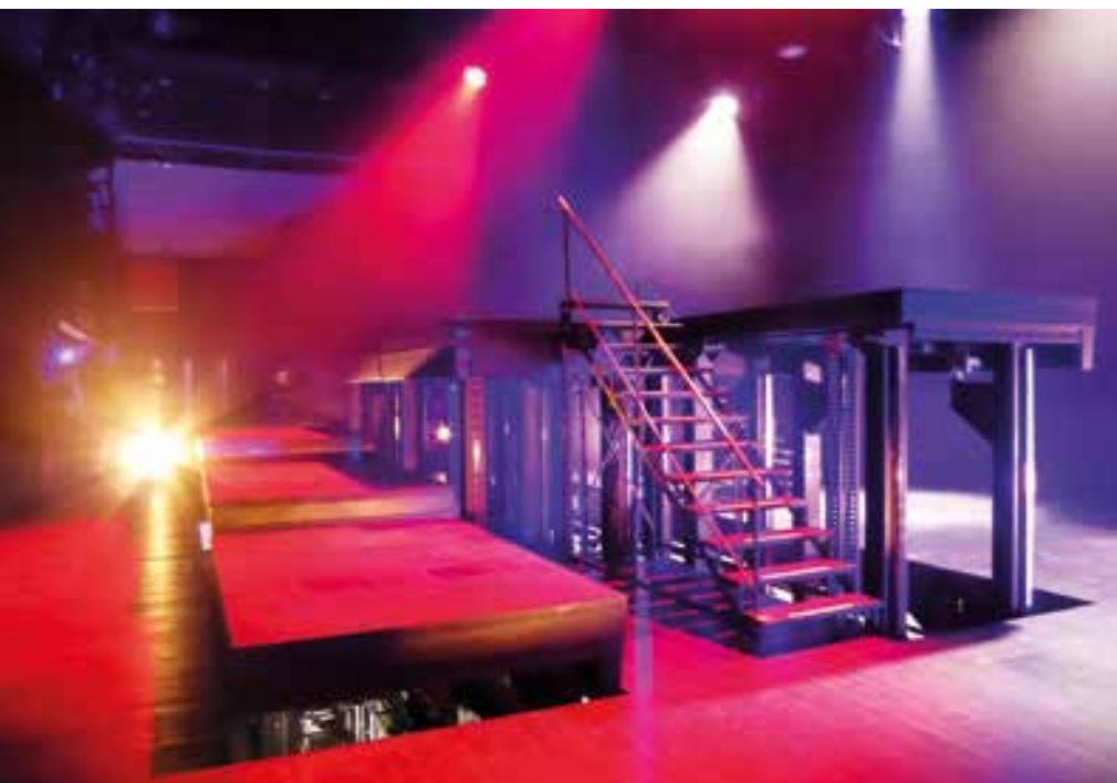
► A dobforgószínpadban süllyedőket építettek, a süllyedők és a kétszintes süllyedők felső lapjaiból ferde síkot lehet létrehozni.
