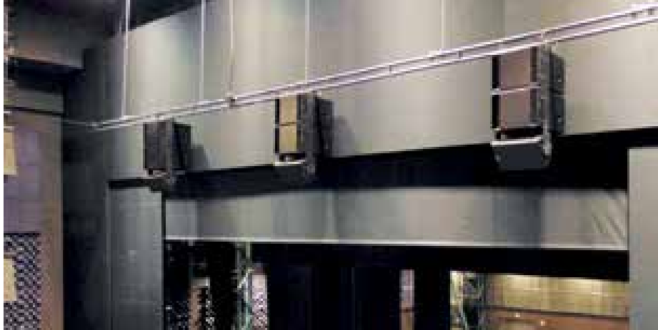
► A nagyterem díszlettartórára szerelt TOP, illetve SUB ládák
