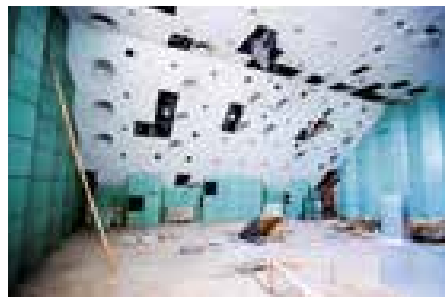
► Az Üzemházban a stúdiók építése
