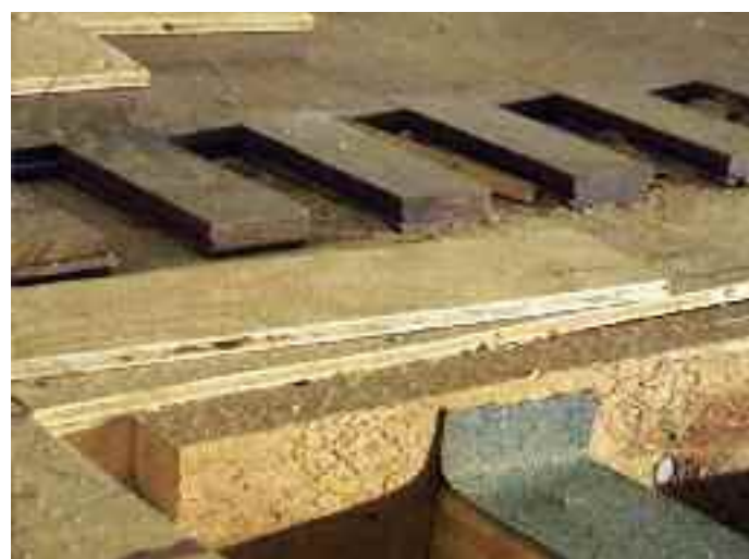
13. ábra: A nézőtérén és a pódiumon készült parkettázás szerkezete
