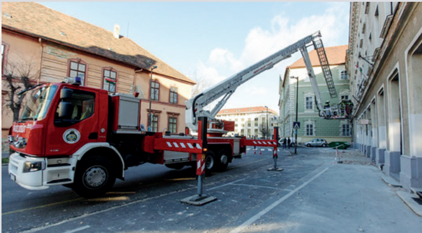
► Tűzoltók bontják az épület homlokzatát
